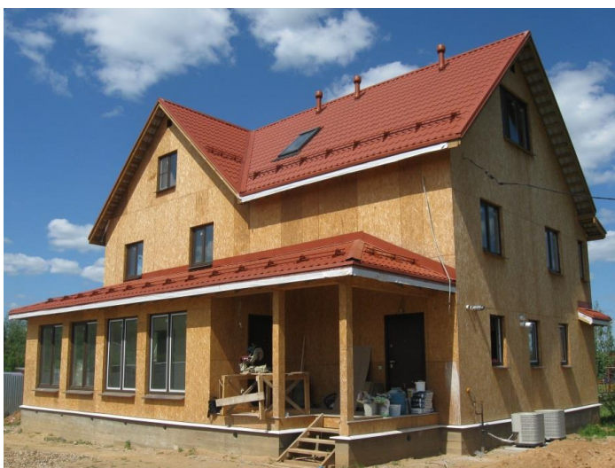
Фото1. Каркасный дом на основе дерева.
