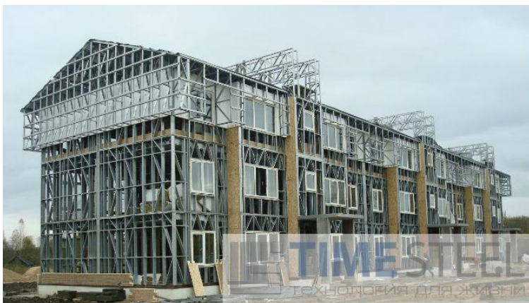
Фото 2. Каркас дома из легких стальных тонкостенных конструкций. Монтаж термопанелей Фрайд непосредственно на стену.
